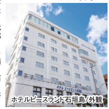
ホテルピースランド石垣島/外観
