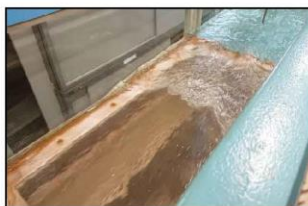
写真9) 上から見た跳水
